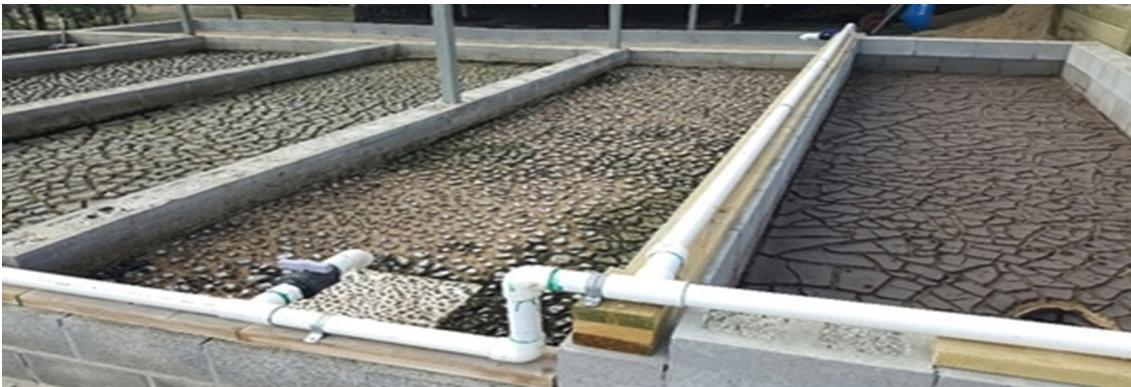
الشكل (2-1-2-6-2-2) صورة للحمأة في أحواض التجفيف الرملية
